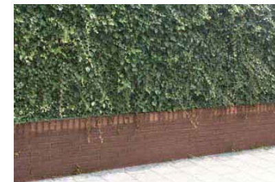
Muur met daarop hekwerk met klim-heesters
