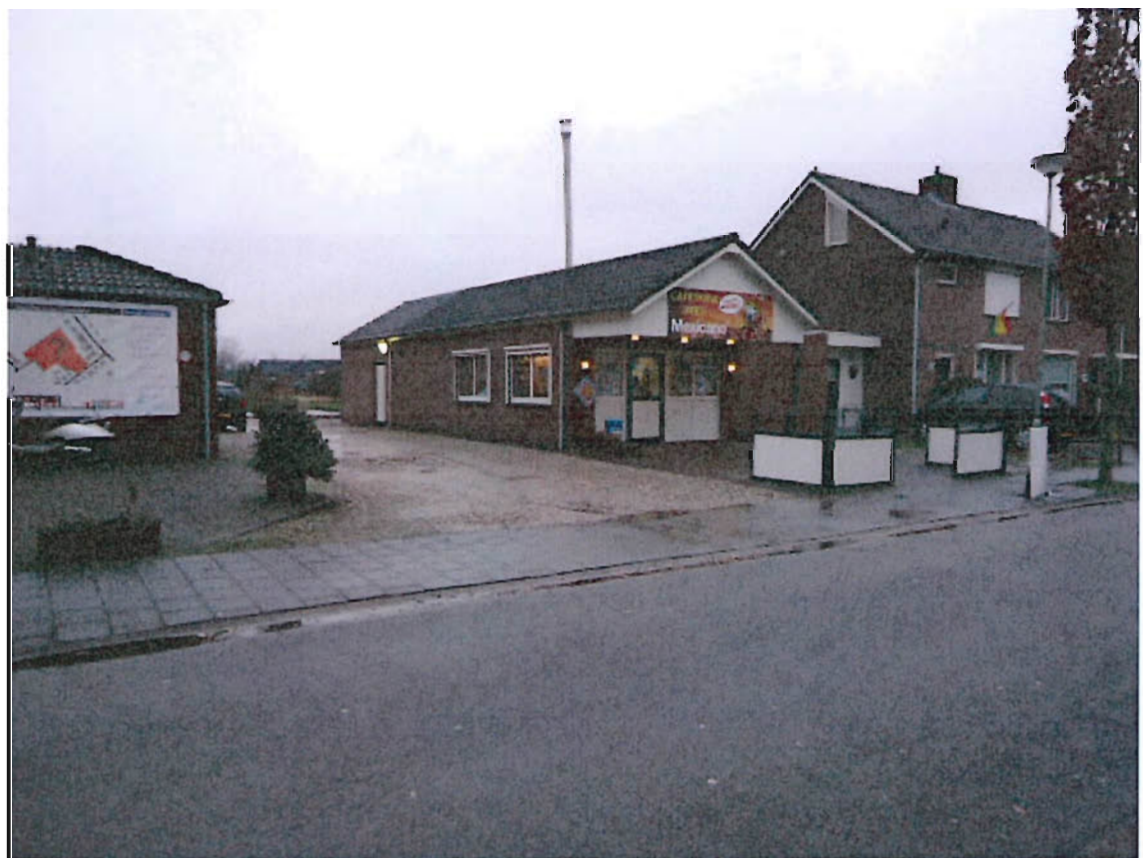
Foto 6: friture met terras en toegang tot parkeerplaatsen (gezien vanuit het zuiden, 29 januari 2013)
