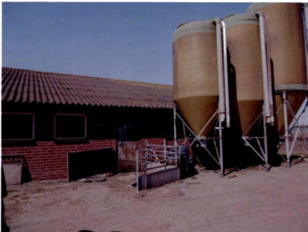
foto 1: te verbouwen gedeelte van de varkensstal gezien vanuit het zuiden (17 april 2014)
