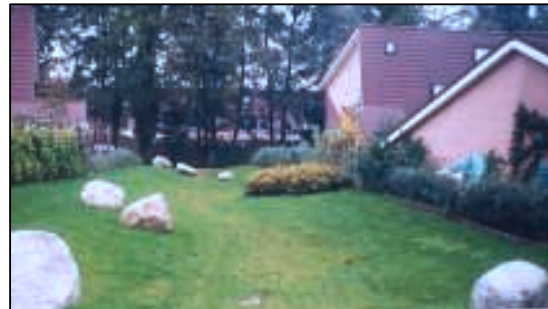
Afbeelding 8: Voorbeeld infiltratiegreppel bij woning
