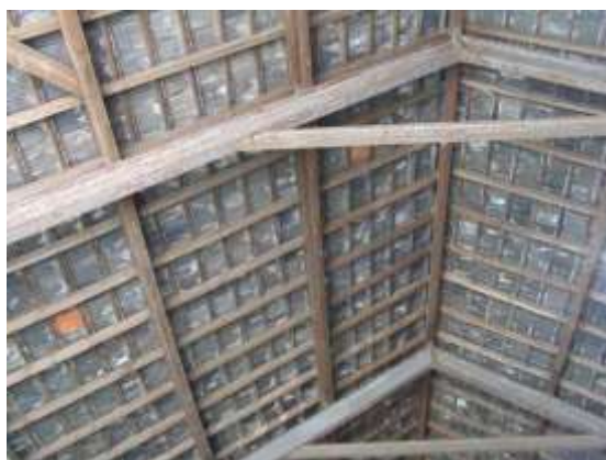
15. De dakconstructie van de schuur.
