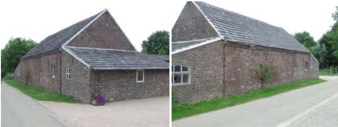
17. De zuidelijke stallen, oost- en zuidzijde. 18. De zuidelijke stallen, zuidzijde.
