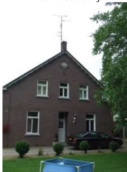
6. De oostelijke kopgevel van de nieuwe boerderij.
