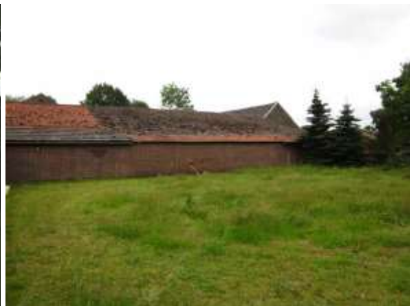
25. De westelijke stallen, westzijde deel noord. rechtsachter de zuidelijke stallen.
