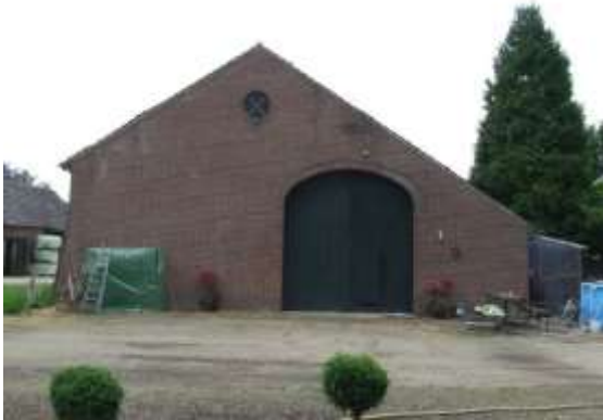
10. De oostelijke kopgevel van de schuur.
