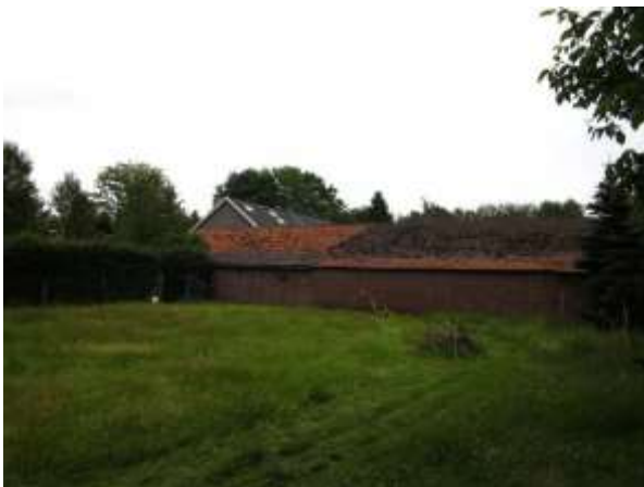
24. De westelijke stallen, westzijde deel noord. Linksachter de boerderij.
