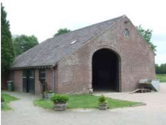
12. De westelijke kopgevel van de schuur.
