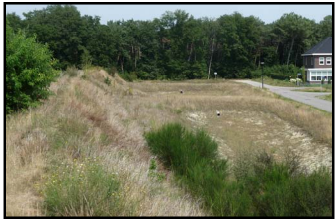
Figuur 4: Gedeelte van de grondwal welke het voormalig Campingterrein omringd en de aanwezige wadi's
