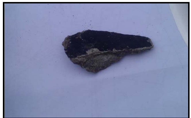
Figuur 6: Asbestverdacht (buis)materiaal. Aangetroffen ter hoogte van de aanwezige halfverhardingslaag
