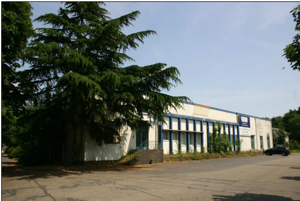
Figuur 5. Voormalige fabriek Beckers
