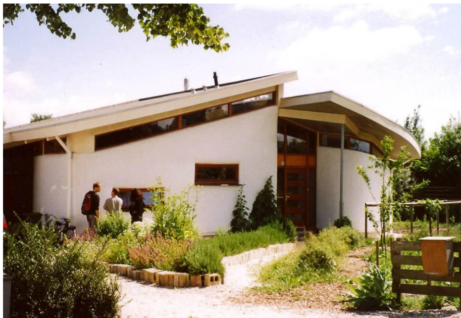
Strobouw woning met stucgevel
