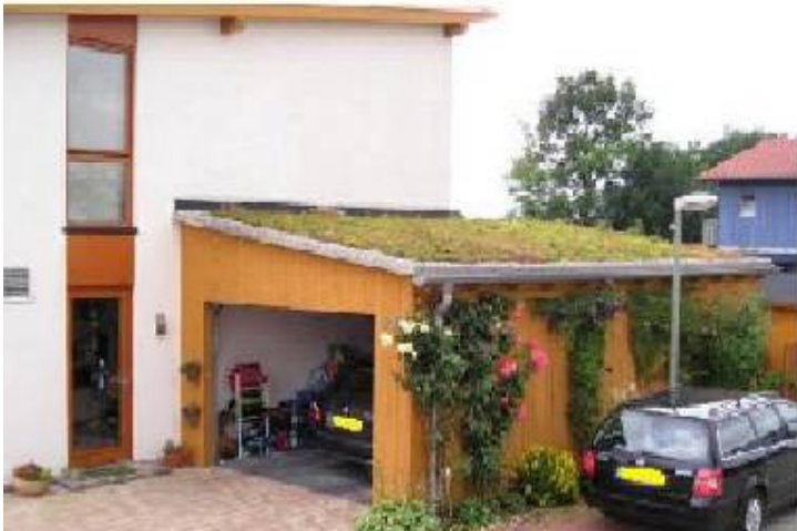
Houten gevel en sedemdak
