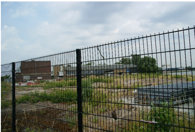
Figuur 6 Impressie van de fundering van de reeds gesloopte gebouwen en nog aanwezige gebouwen op de achtergrond
