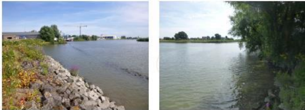
Figuur 8 Foto-impressie van het de oevers binnen het plangebied, linker foto: oeverbeschoeiing van stortsteen (betonzuilen) en een vooroeverdam. Rechter foto: stortsteen met bomen (wilgen) (bron: toetsingskader waterkwaliteit).
