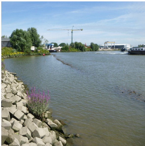
Figuur 2.3. Foto-impresie van het de oevers binnen het plangebied, oude en nieuwe betonzuilen in meer detail (boven) en de opwerveling van sediment bij passage van een schip (foto's onder).
