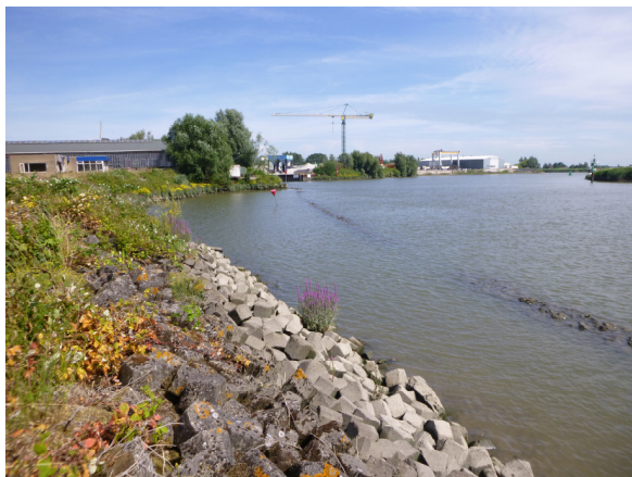
Figuur 2.2. Foto-impresie van het de oevers binnen het plangebied, linker foto: oeverbeschoeiing van stortsteen (betonzuilen) en een vooroeverdam. Rechter foto: stortsteen met bomen (wilgen).
