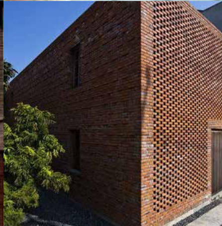
Containerplek, nutskasten , trafo/camflagebox
