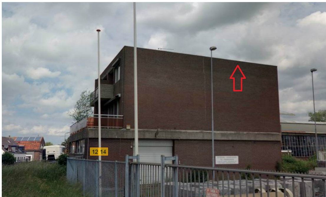
Figuur 3.2 Locatie paarverblijfplaats gewone dwergvleermuis (rode pijl) in de spouw van de zuidgevel van Groenendijk 12/14. Open stootvoegen worden gebruikt om de spouw te bereiken.
