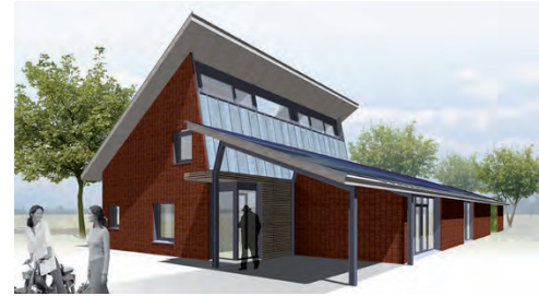
lessenaarsdak met zonnepanelen
