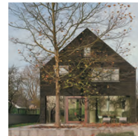
dwarskap met hout- en glasgevel
