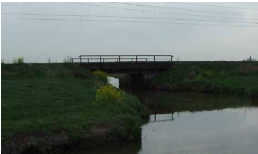
Derde Tocht en onderdoorgang spoor (zone 6)
