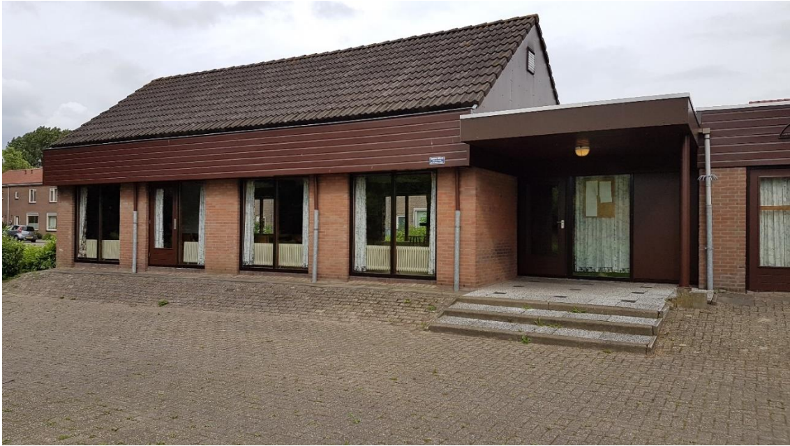
Figuur 2 - Ingang gebouw vanaf parkeerterrein.
