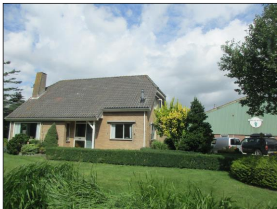
Foto 5: Bedrijfswoning aan de Middelweg 8 van het plangebied
