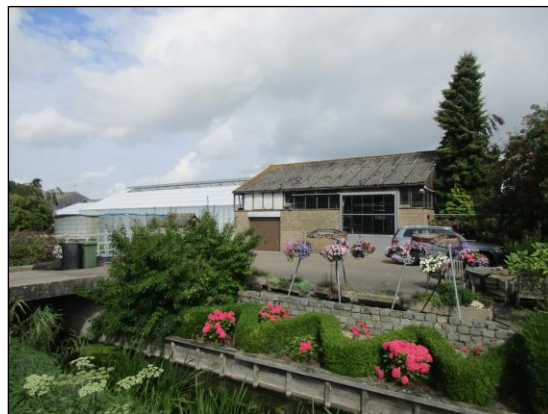
Foto 6: Loods en kassen aan de Middelweg 4 van het plangebied
