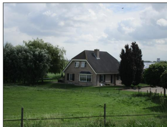
Foto 10: Bedrijfswoning aan de Rottekade 18 in het plangebied
