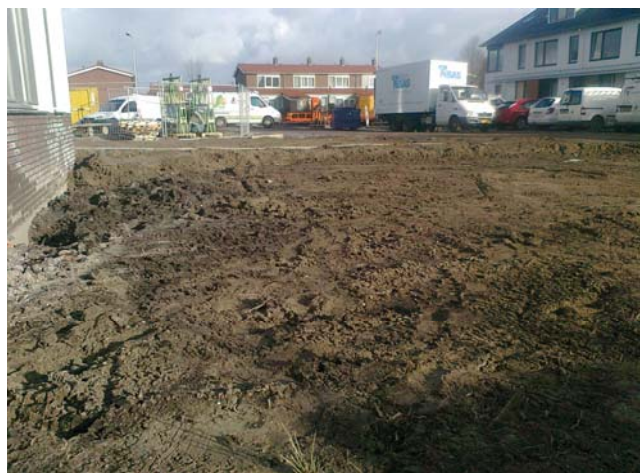
Foto 5: ontgraven voorzijde bouwnummer 2
