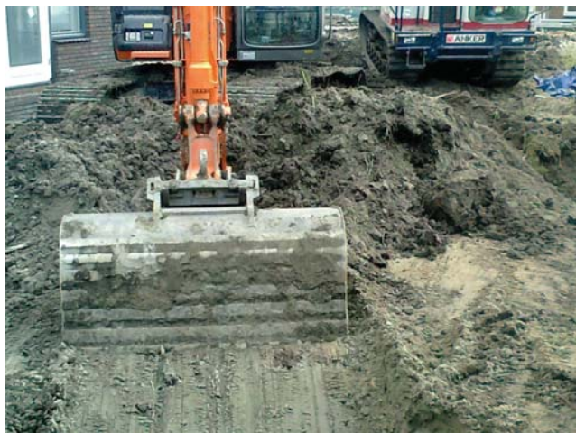
Foto 1: ontgraven tuinen blok 02
