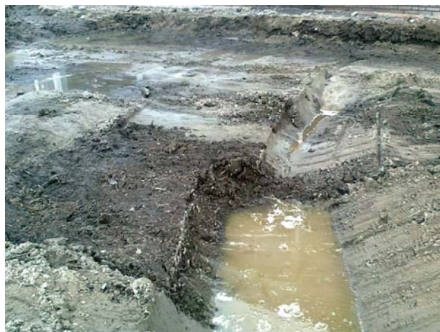
Foto 2: ontgraven tuinen blok 02
