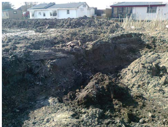
Foto 2: ontgraven achterzijde bouwnummer 1
