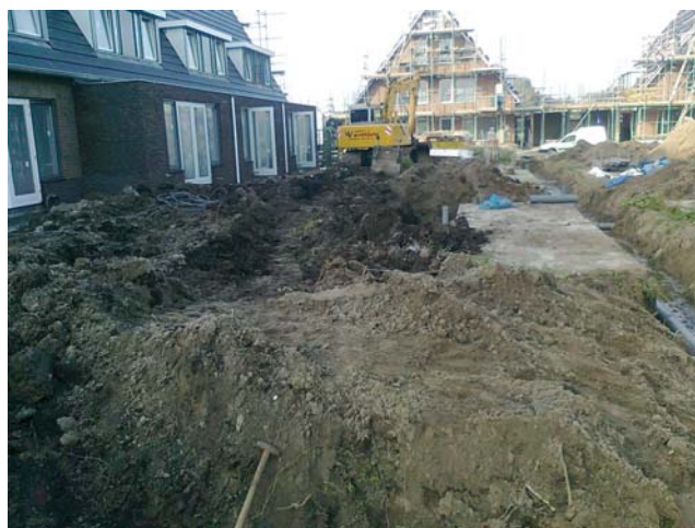
Foto 4: aanleg hemelwaterafvoer blok 01
