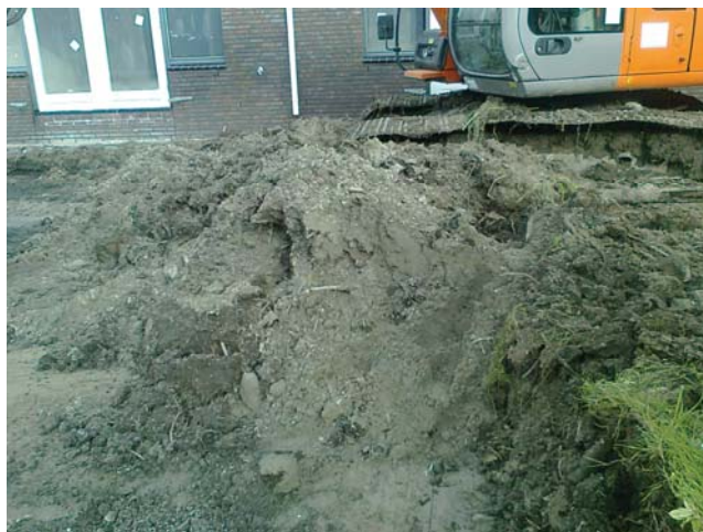
Foto 2: te verwijderen talud tuinen blok 03
