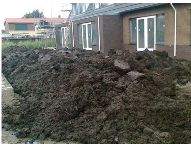
Foto5: niet geëgaliseerde aanvulgrond blok 02
