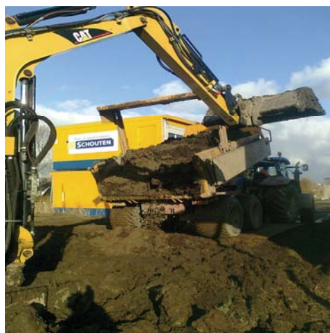
Foto 2: aanvoer aanvulgrond bouwnummer 2
