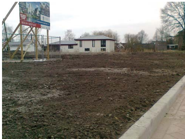
Foto 6: geëgaliseerde aanvulling bouwnummer 1
