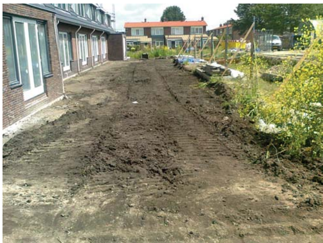
Foto 1: ontgraven tuinen blok 03
