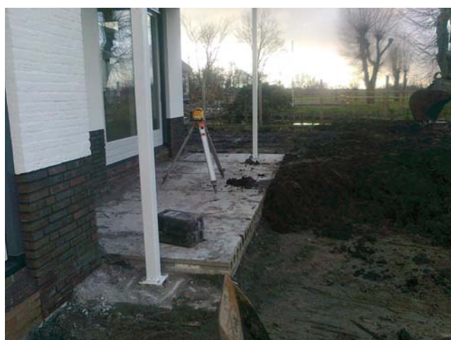
Foto 3: aanvullen achterzijde bouwnummer 2
