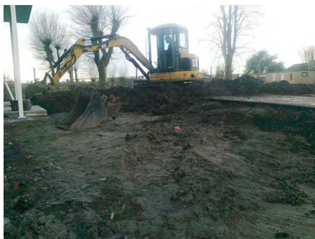
Foto 4: aanvullen achterzijde bouwnummer 2
