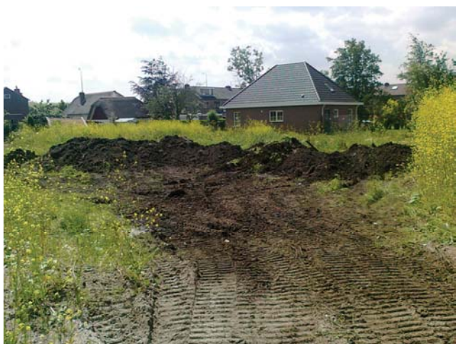
Foto 3: verwijderde grond uit tuinen blok 03
