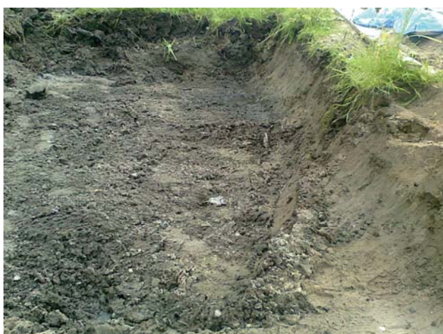
Foto 3: ontgraven tuinen blok 02
