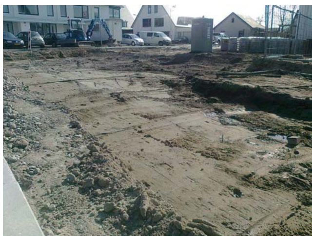
Foto 3: ontgraven noord-oostzijde bouwnummer 1
