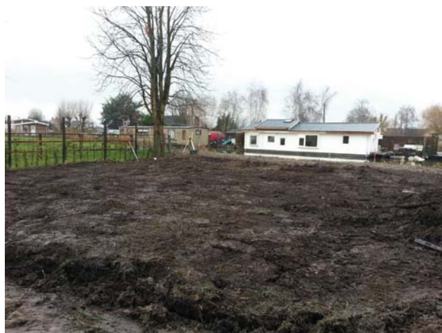
Foto 1: ontgraven achterzijde bouwnummer 2
