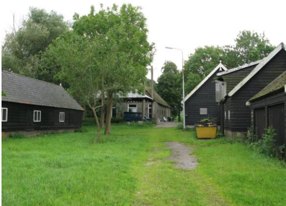
Bedrijfsbebouwing in het bouwvlak.
