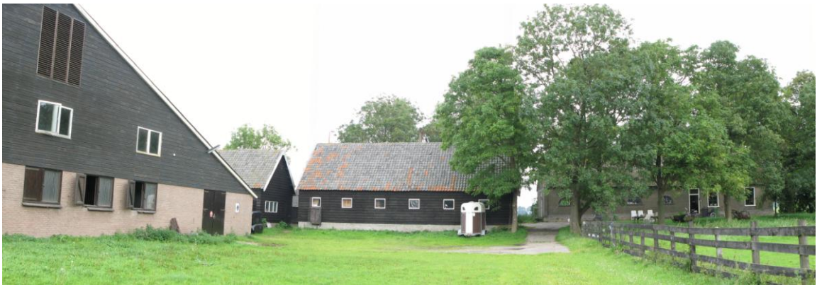
Links de paardenstal, midden diverse bedrijfsbebouwing en rechts de boerderij.
