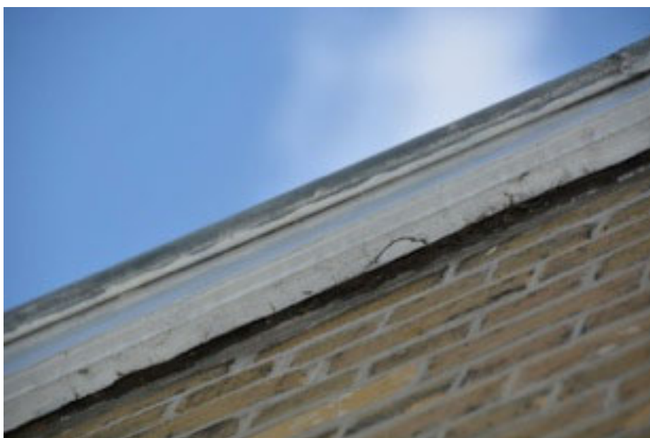
Foto 2 Detailopname daklijst/boeiboord bij het pand 's Gravenweg 108 (foto Tukker architectuur en advies).
