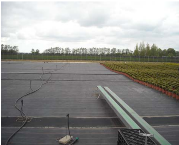
Foto 15: vloeistofdicht gedeelte kwekerij
