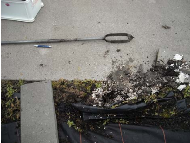
Foto 13: polystyreen onder kavelpad 1.2
