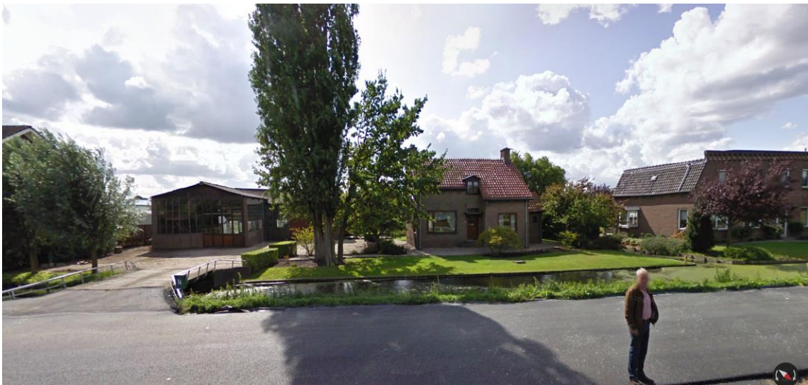
Afbeelding 2.2.: de bestaande woning Eerste Tochtweg 24 (centraal op de afbeelding) met links daarvan de daarbij behorende schuur. Bron: Google Streetview
