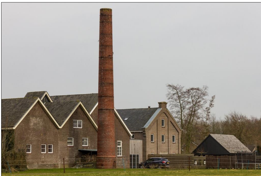
Figuur 4 Voormalig zuivelfabriek 'De Toekomst' Rinsumageest
