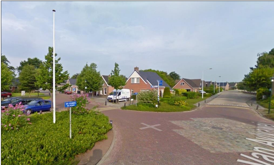
Figuur 6. Overgang Tjaerdawei en Rjochthusstrjitte (Bron: Google Streetview)
