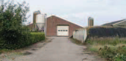
Sleufsilo's op het voorerf
