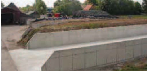
Sleufsilo's op het achtererf
