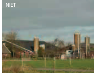
Silo's met erfplanting afschermen
