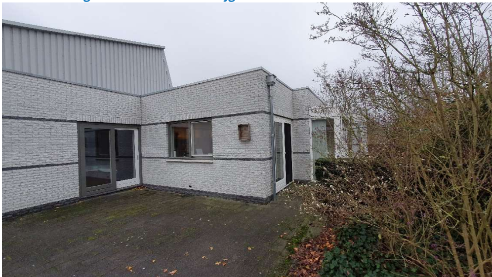
Foto 5: achtergevel keuken en linkerzijgevel slk 1
