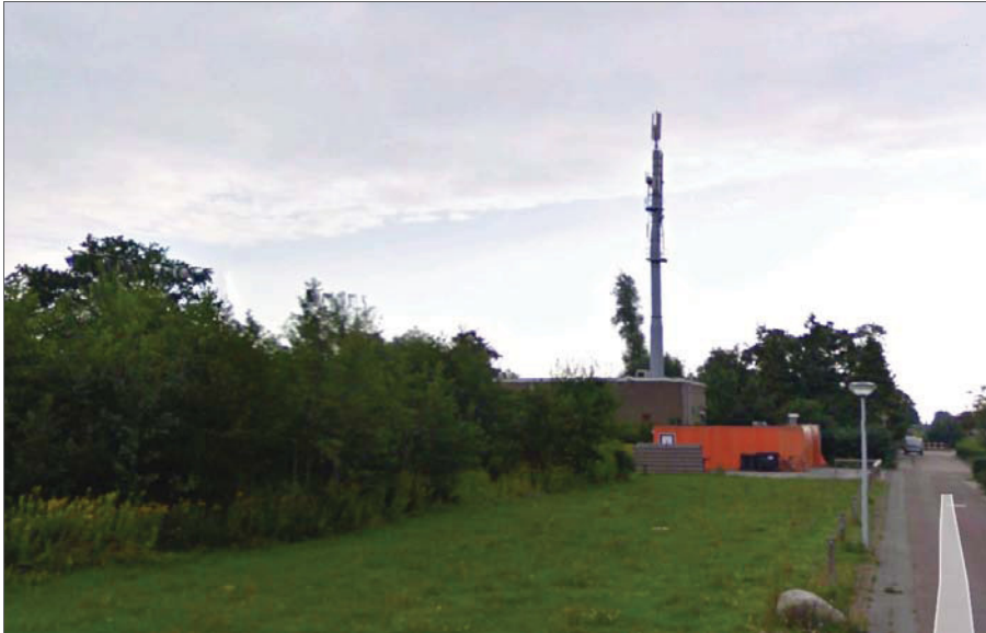
Figuur 15. De zend- en ontvangstinstallatie aan de Iisbaanstrjitte
