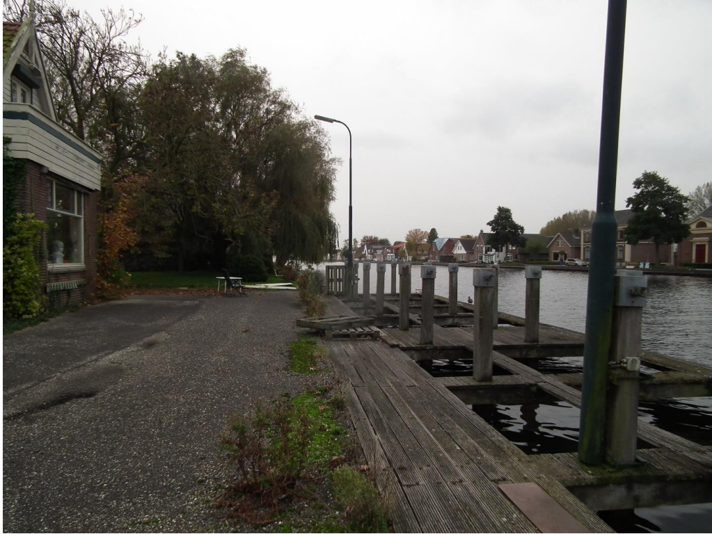
Figuur 3 Aan de oostzijde grenst het perceel aan de watergang de Oude-Wetering. De watergang is beschoeid en er is een steiger aanwezig.
