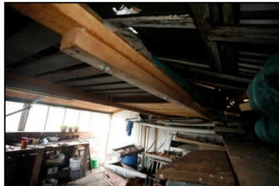
Figuur 7. Binnenkant schuur aan de westkant van de onderzoekslocatie.
