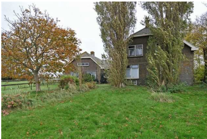
Figuur 3.2 Bestaande situatie achterzijde
