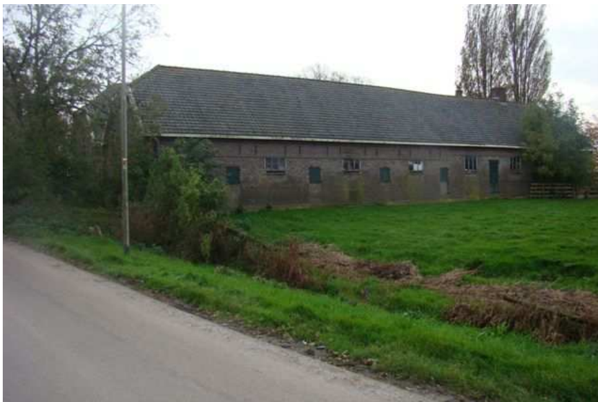
Figuur 3.8 Bestaande noordgevel vanaf de Boddens Hosangweg
