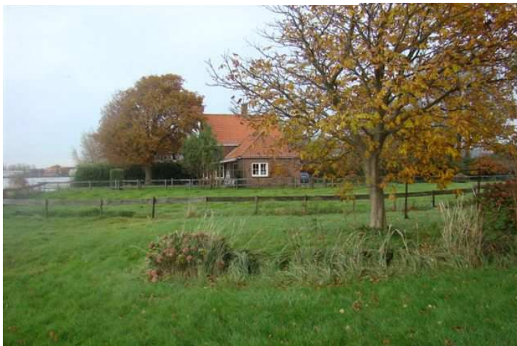
Figuur 3.5 Bestaande situatie Boddens Hosangweg 114
