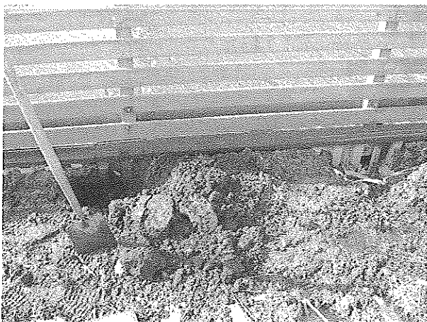
Foto 17: sleuf beschoeiing H3
