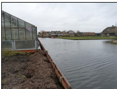
Figuur 6. Beschoeiing langs de oever.
