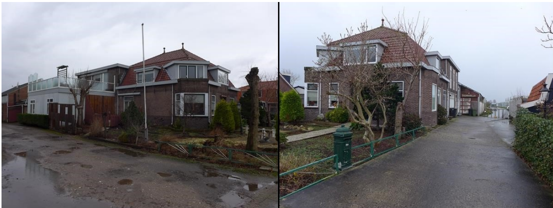
Linker en rechterzijgevel vanaf Zuideinde
