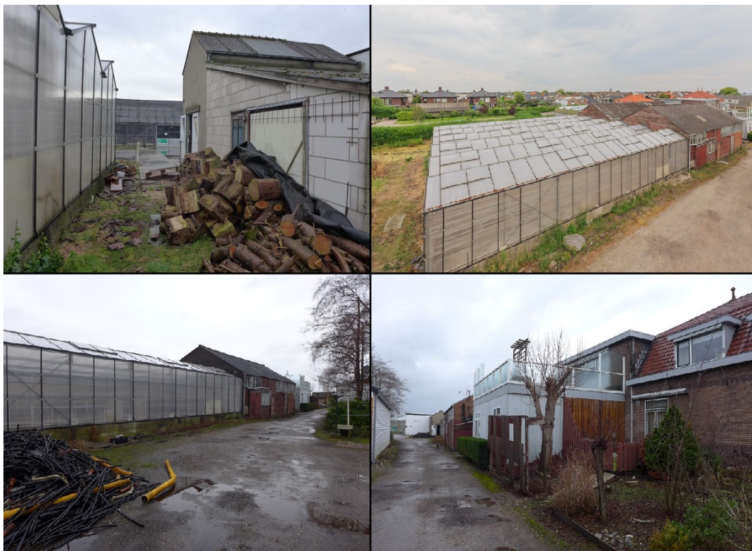
Achterzijde glazen tuinkas en bebouwing (boven) en overpad (onder) met terrein buren (links) en woningen (rechts)
