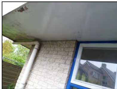
Figuur 12. Ruimte dakrand.
