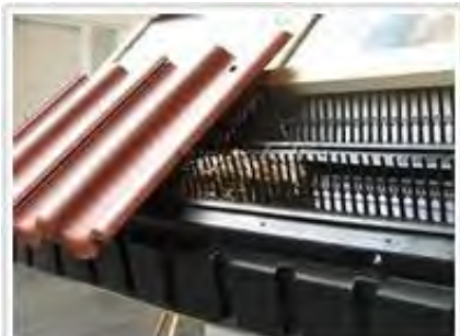
Figuur 20. voorbeeld vogelvide onder eerste rij dakpannen (bron: Vogelbescherming)
