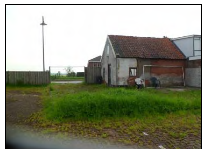
Figuur 8. Deels te slopen woonhuis nr. 15.
