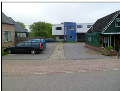
Figuur 3. Vooraanzicht onderzoekslocatie (foto genomen vanaf Zuidweg).
