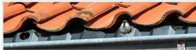
Figuur 21. vooraanzicht vogelvide onder eerste rij dakpannen (bron: Vogelbescherming)
