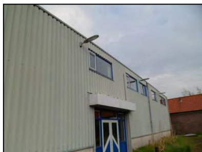
Figuur 7. Te slopen bebouwing.
