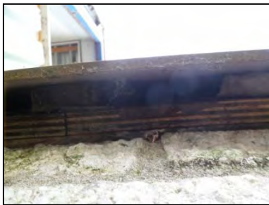
Figuur 11. Ruimte achter betimmering.
