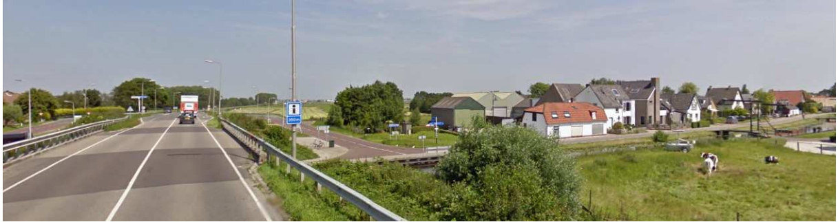
Foto 2. Aanzicht provinciale weg N445 (bron: Google Maps)
