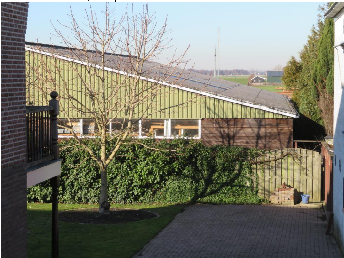
Schuur, met golfplaten dak en plaatstaal aan de buitenzijde.
