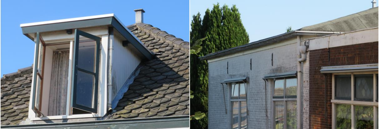
Aansluitende pannen en dichte gevel
