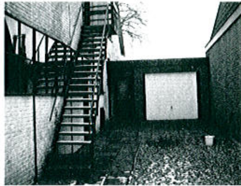
Foto 2 opname van de onderzoekslocatie
