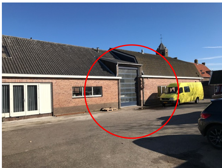
Foto 2: Locatie te realiseren appartementen
