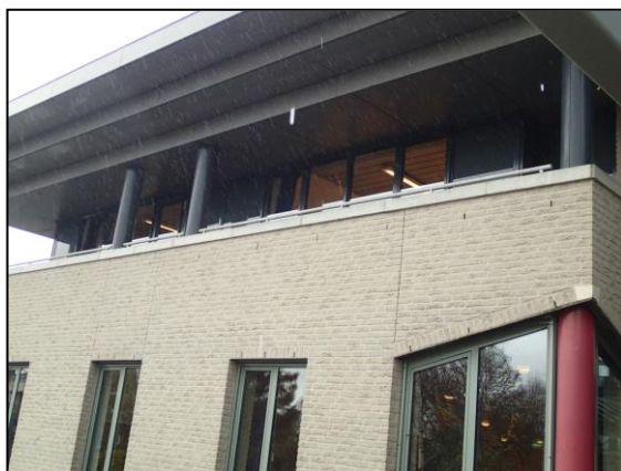
Foto 1: Open stootvoegen in bebouwing.
