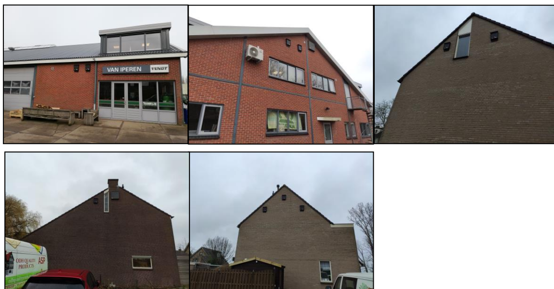
Foto 3-7: Opgehangen tijdelijke voorzieningen.
