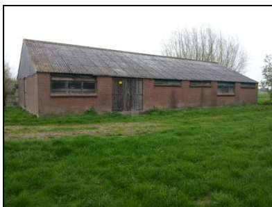
Figuur 13. Te verwijderen loods.
