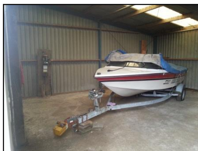
Figuur 10. Overzicht binnenzijde loods.
