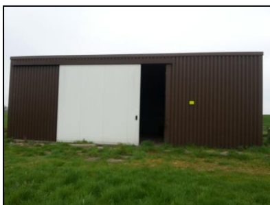
Figuur 9. Te verwijderen loods.
