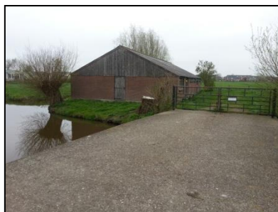
Figuur 14. Te verwijderen loods.
