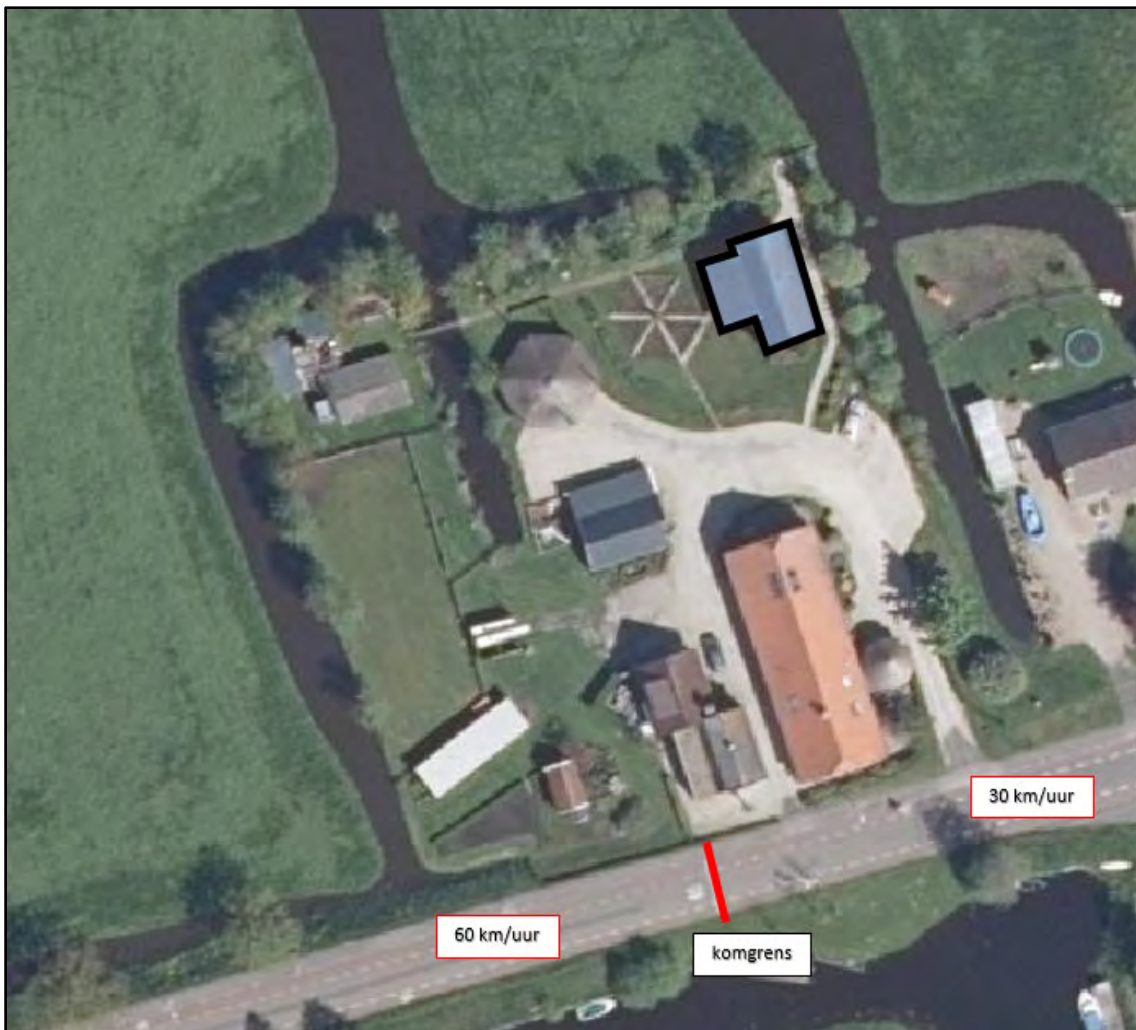
Figuur 1 Ligging te transformeren kantoorpand naar woning (hierna: het pand) en de komgrens in de Van Klaverweijdeweg
