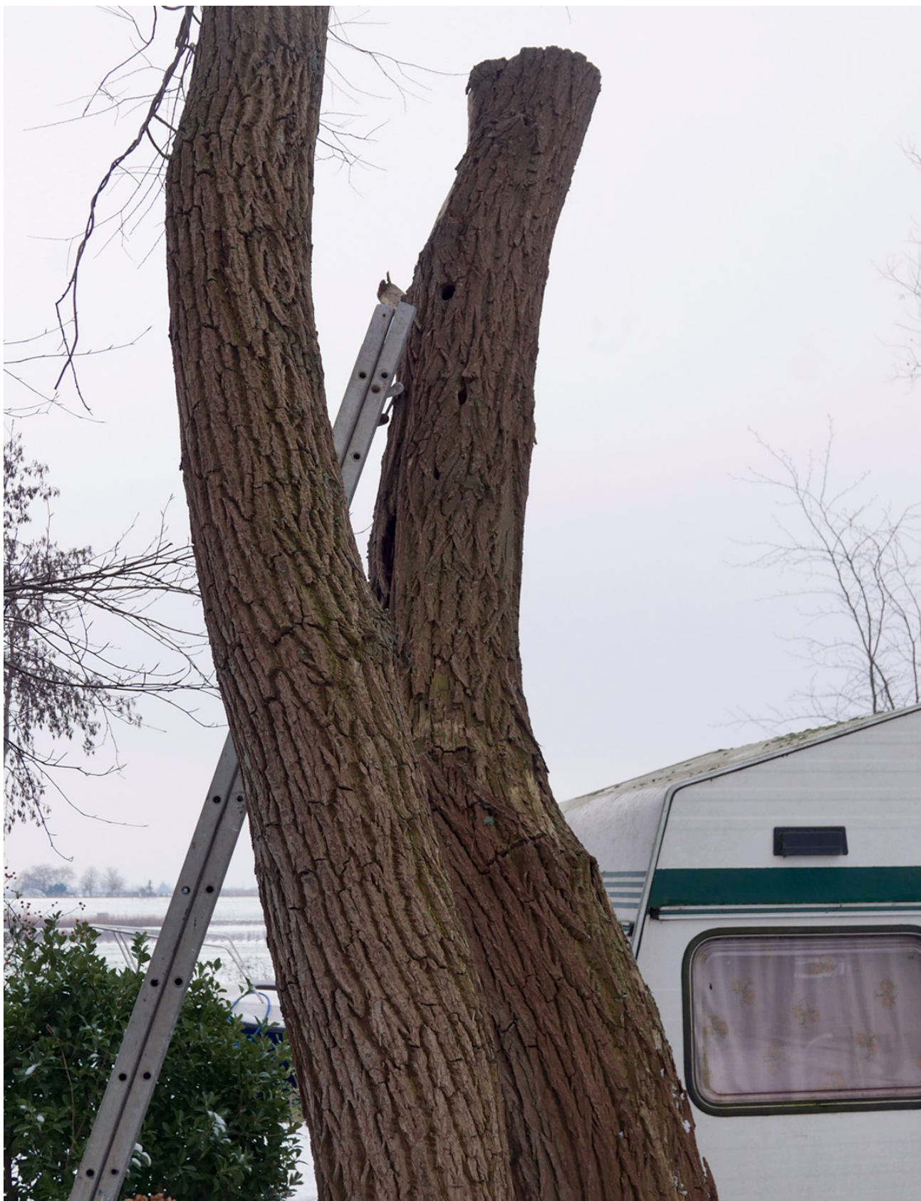
Afb.2: Inspectie van aanwezige holten.
