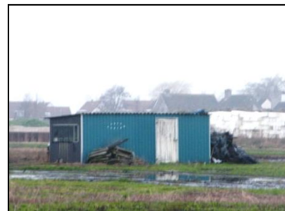
Figuur 8. Metalen schuur op noordelijk deel.
