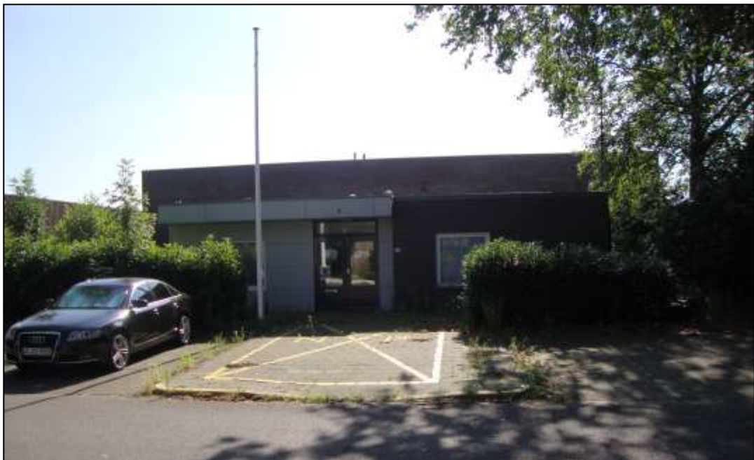
Perceel/pand met maatschappelijke bestemming, aan de Borrekuilstraat 124
