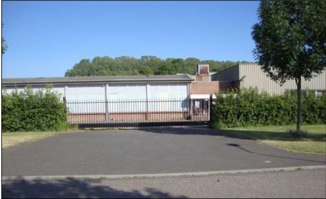
Perceel/pand met maatschappelijke bestemming, aan de Borrekuilstraat 50
