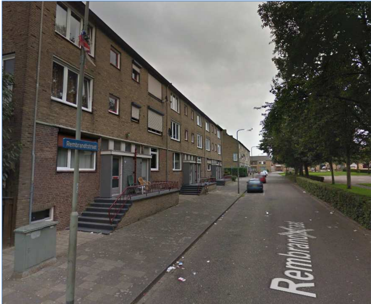
Figuur 8. Aanwezige bebouwing aan de Rembrandtstraat met half ingegraven verdieping.
