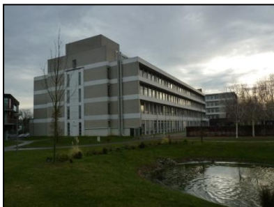
Figuur 3. Gebouw St. Odillia.
