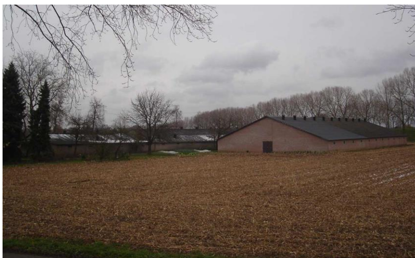
Foto's bestaande situatie
