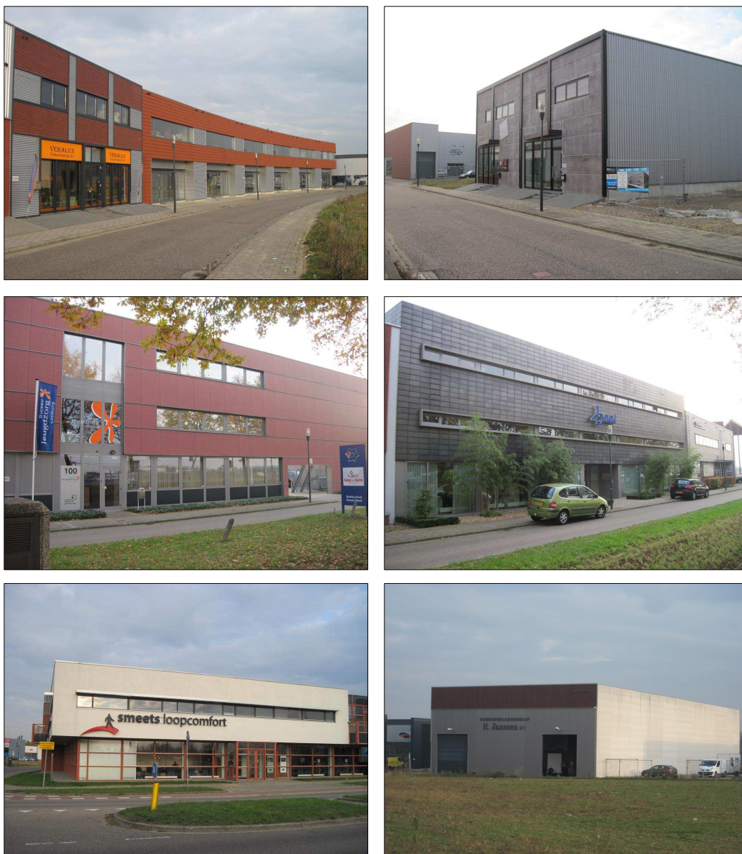
Afbeelding 9 t/m 14. Bedrijfsbebouwing op het bedrijventerrein Bergerweg-Zuid.
