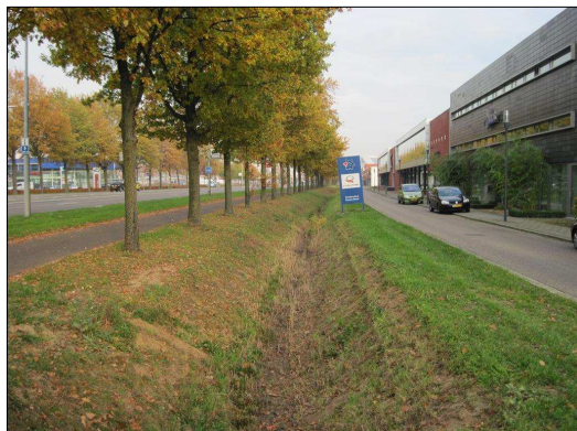
Afbeelding 17. De groenstrook met afwateringssloot langs de Bergerweg.
