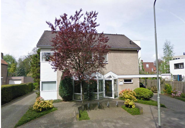
Huidige situatie Parklaan 21a (bron: Google Maps)
