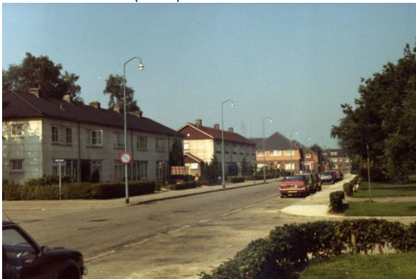
De montage woningen aan de dr. Philipsstraat voor renovatie
