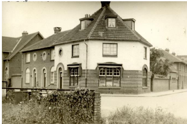
Historische foto eerste deel sociale woningbouw (1919 Stuyt)
